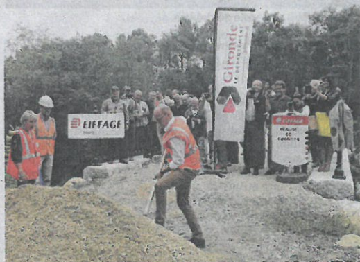
Les élus Jean-Luc Gleyze et Isabelle Dexpert ont donné le top départ du chantier à Bernos-Beaulac mardi dernier. PHOTO A.D.
